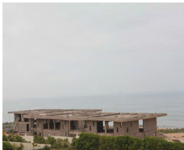
Etat actuel du bâtiment
