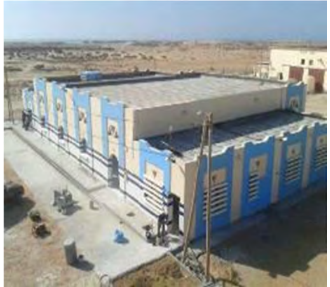
Après la mise à niveau
