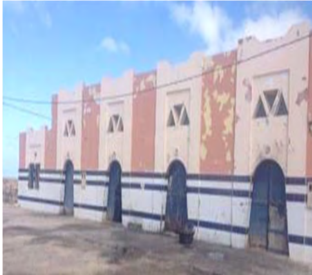
Avant la mise à niveau
