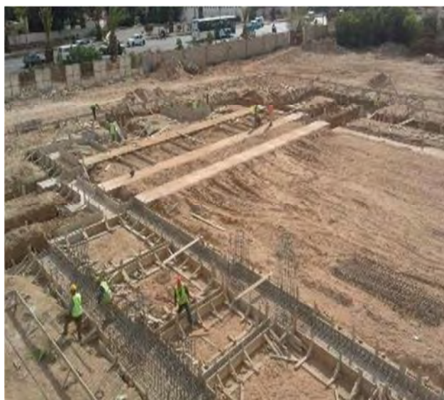
Démarrage des travaux
